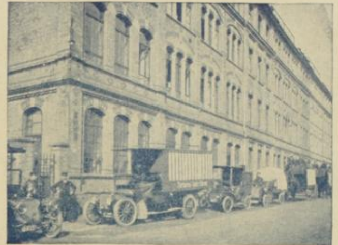
Hauptgebäude mit Fuhrpark.
