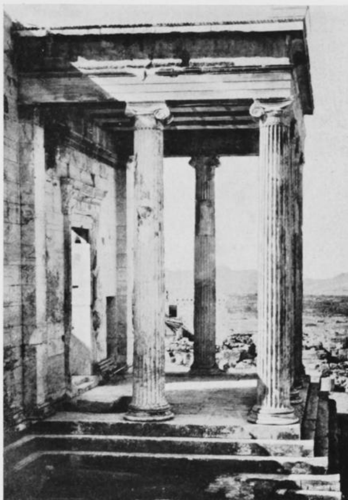
12 Erechtheion-Vorhalle. Der figürliche Fries ist abgefallen.
