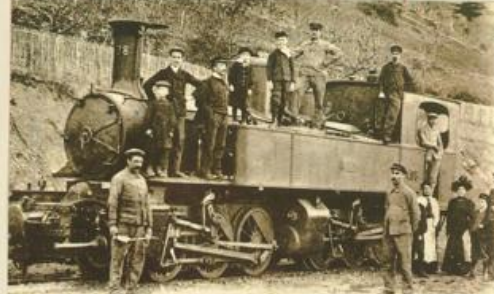
La Lezère - Florac à Ste-Cécile d'Audorge - Locomotive de la C e C.F.D 4 cylindres, 6 essieux couplés, poids 46 tonnes
