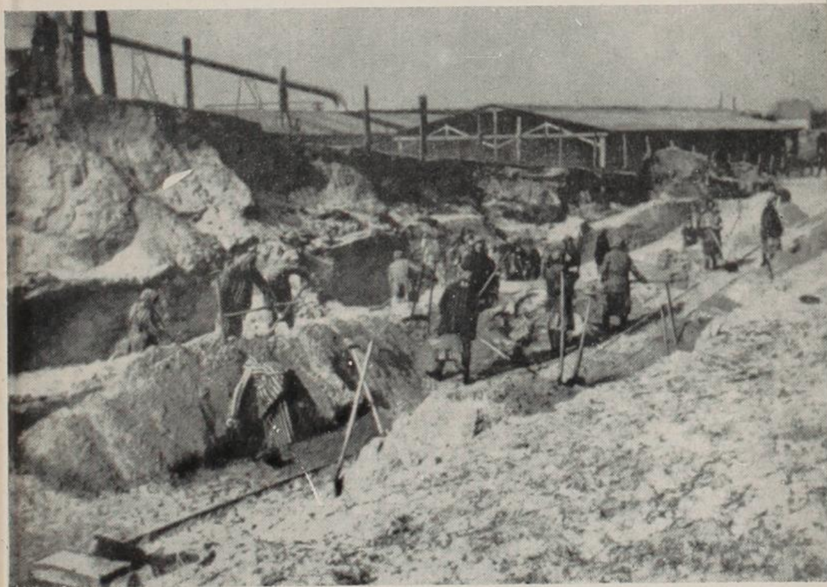
Häftlinge bei Ausschachtungsarbeiten im Winter 1939
