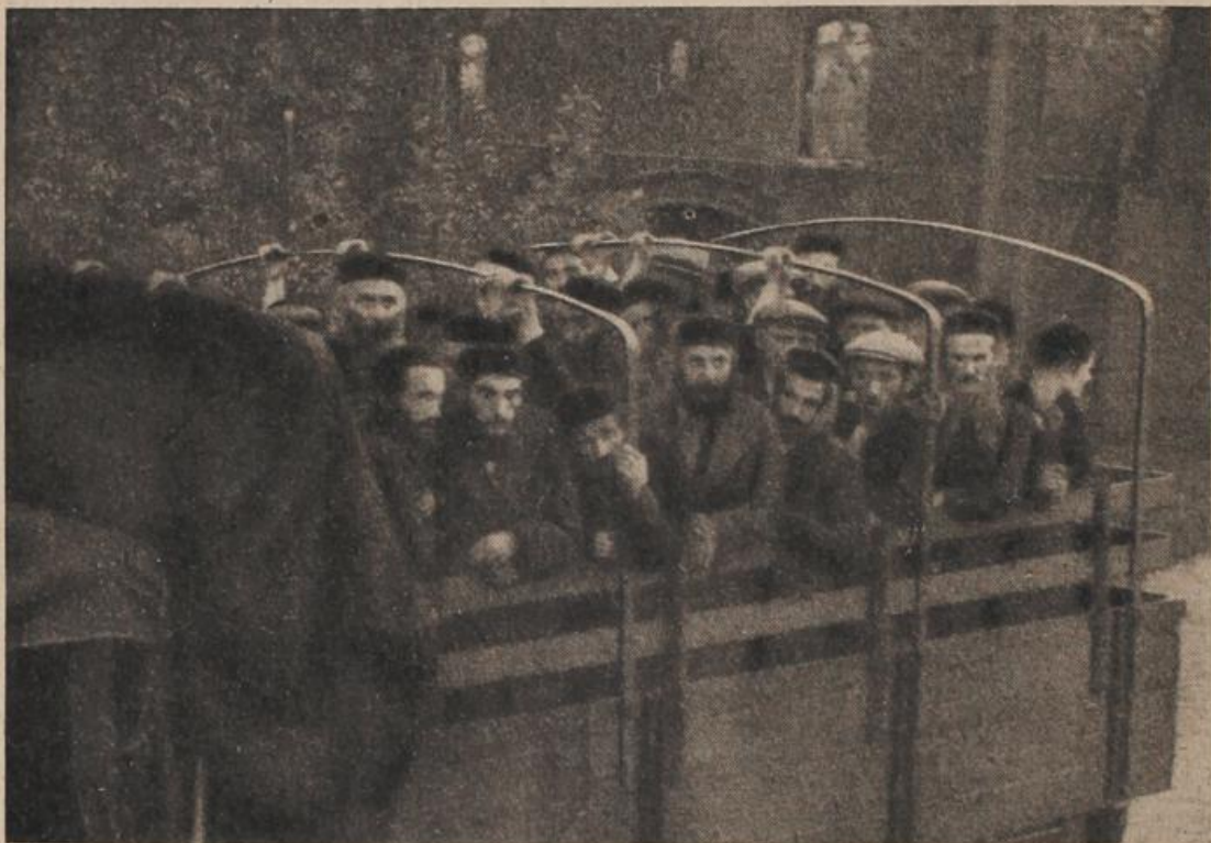
Von der SS zusammengetriebene Juden werden nach Kamienna verschleppt
